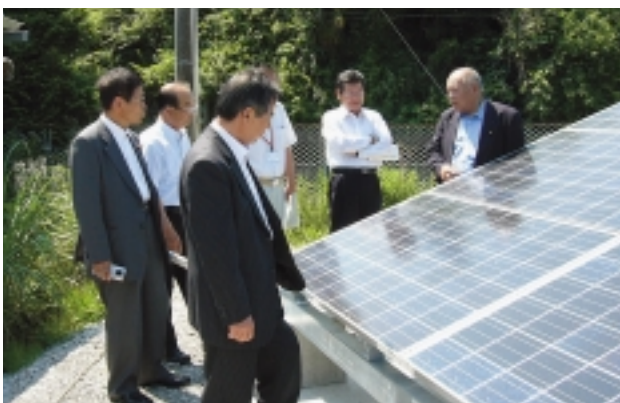
城東中学校太陽光発電施設
