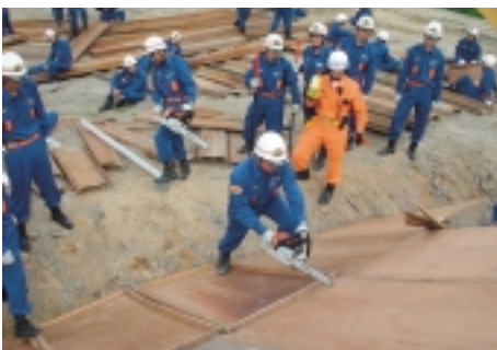
倒壊家屋撤去訓練
