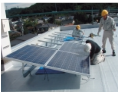
太陽光パネルの設置が進められている
