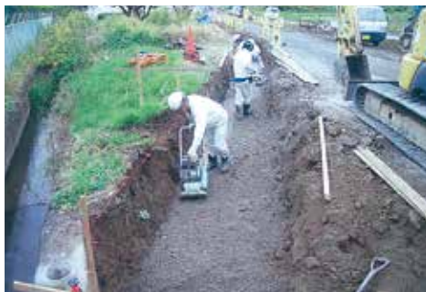
公共道路側溝工事
