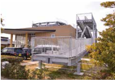
大東福祉会くによす苑の津波避難施設
