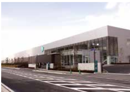
操業を開始した新病院隣接の工業団地
