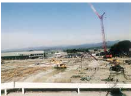
菖蒲ヶ池工業団地に建設中の物流会社
