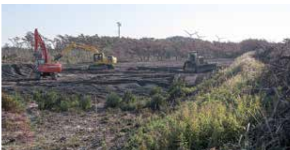
協働による海岸防災林の強化策「掛川モデル」が施工(沖之須)
