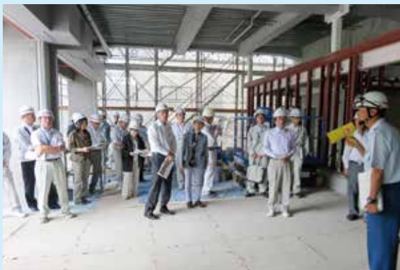
中央消防署新庁舎建設
