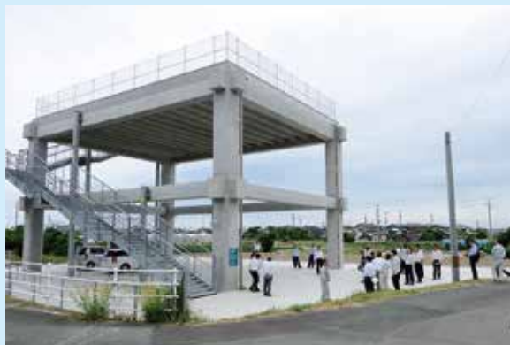
津波避難タワー
