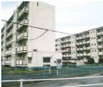
入居が停止されている雇用促進住宅大浜宿舎(大坂)
