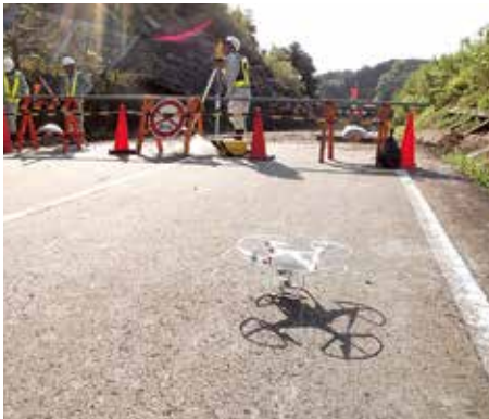
公共土木施設災害現場にて 測量設計コンサルタント所有のドローンを利用
