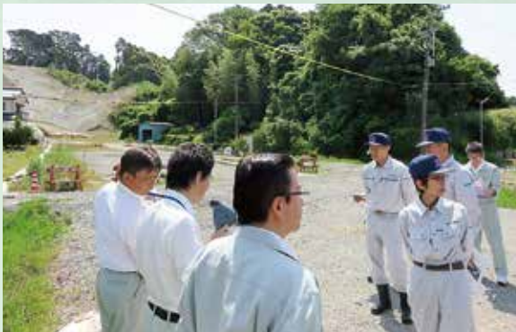
市道桜木中横断線の工事箇所
