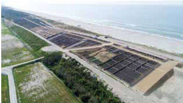
整備が進む「掛川潮騒の杜」
