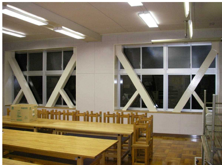
耐震補強工事の例（内部）
