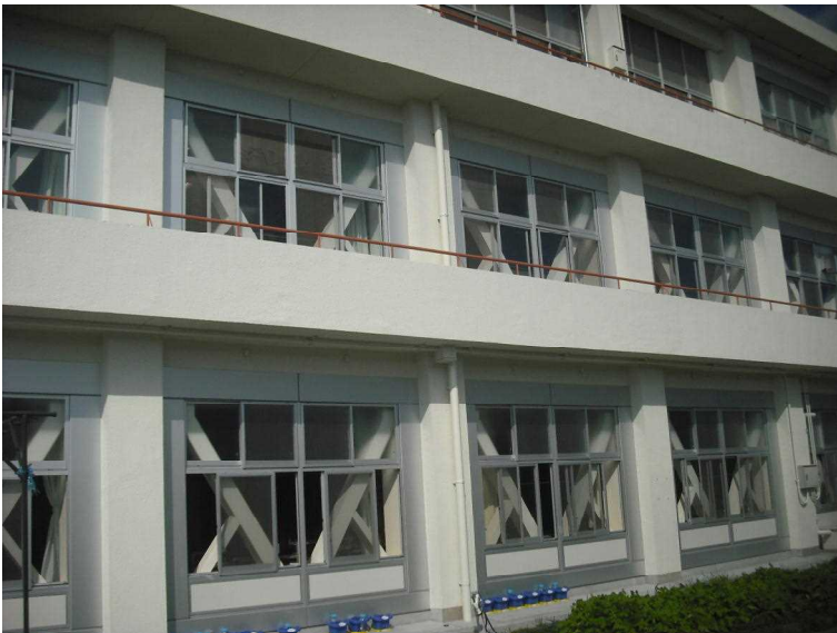
耐震補強工事の例（外観）
