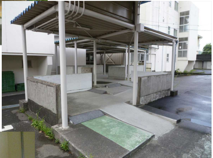
渡り廊下へのスロープ設置例
