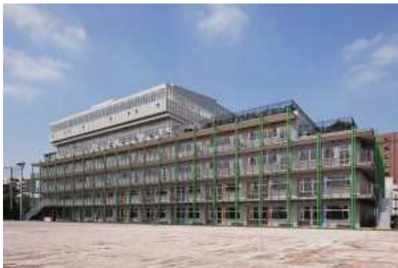
グラウンド側から見た校舎外観
