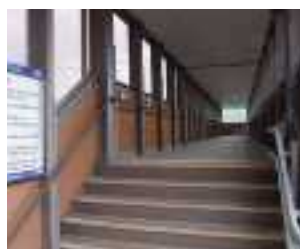
連絡通路内部
