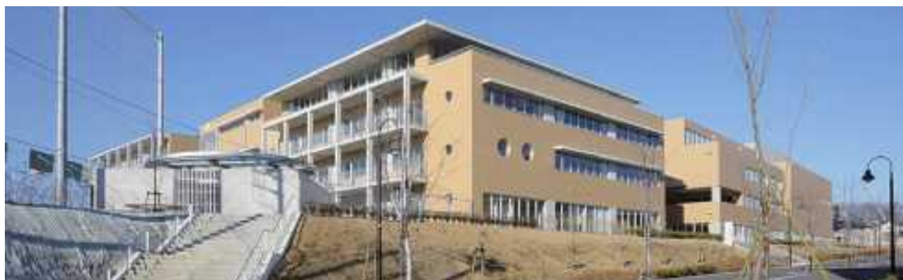
校舎外観南東面
