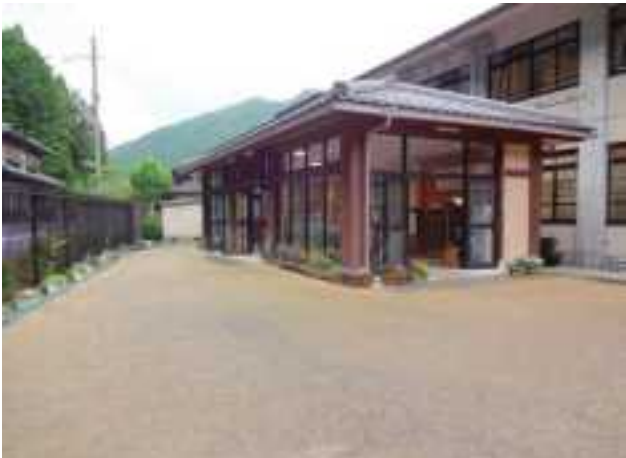
校舎中央付近に増築した小中合同の昇降口。職員室が隣接しており、人の出入りなどの管理も行いやすい計画となっている。
