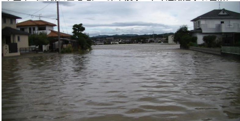
下垂木1区(新田住宅地) 床下浸水22戸、道路冠水(3箇所)
