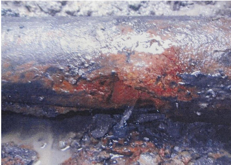
配管の腐朽
