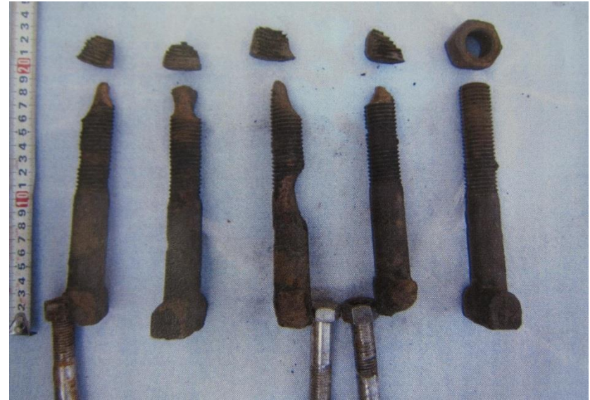
ボルトの腐朽
