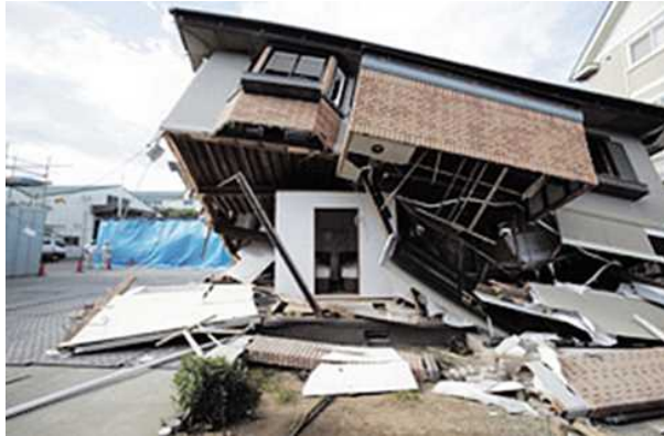
倒壊実験後のシェルター外観
